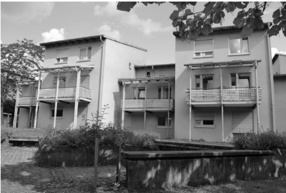
Östliche Ansicht, Balkonkonstruktionen
