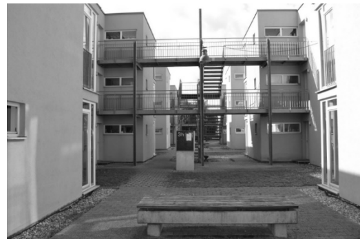
Stahltreppenkonstruktion und Brücken
