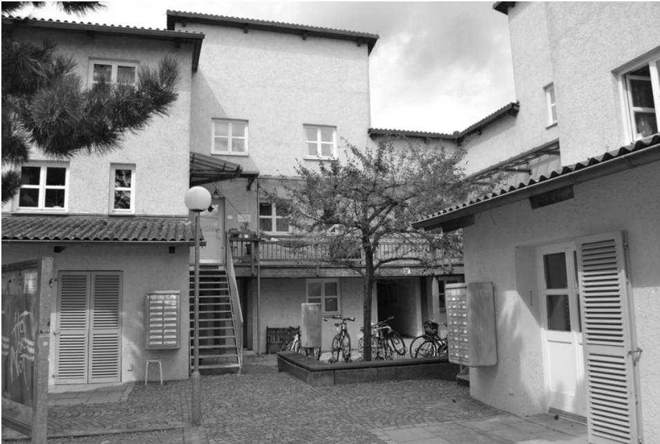
Blick auf Innenhof und Ostseite des Studentenwohnheim Straußbäcker I
