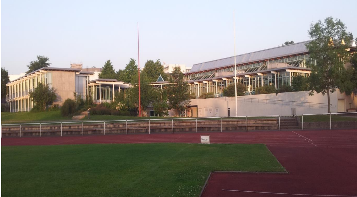
Abb. 1: Blick vom Stadion aus auf die Sporthalle (rechts), das Institutsgebäude (links), in der Mitte das pyramidenförmige Dach des Abgangs zur Sporthalle.
