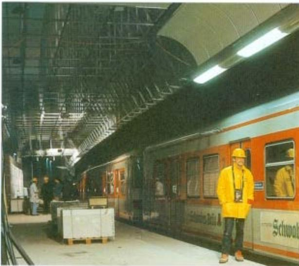
Abb. 8 Die Station Universität im Ausbau; der Bodenbelag fehlt noch. Oben sieht man die Tragkonstruktion der abgehängten Decke, im Vordergrund ein Musterstück der künftigen Bahnsteigbeleuchtung.
