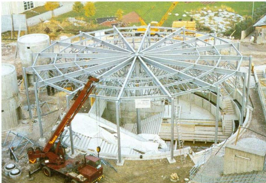
*Abb. 4 Den Ausgang von der Station Universität zum Universitätszentrum überspannt ein Glasfaltdach mit 25 m Durchmesser, hier noch ohne Verglasung. Links daneben die oberen Ausgänge der beiden Aufzüge zu den 21,5 m tiefer gelegenen Bahnsteigen.*
