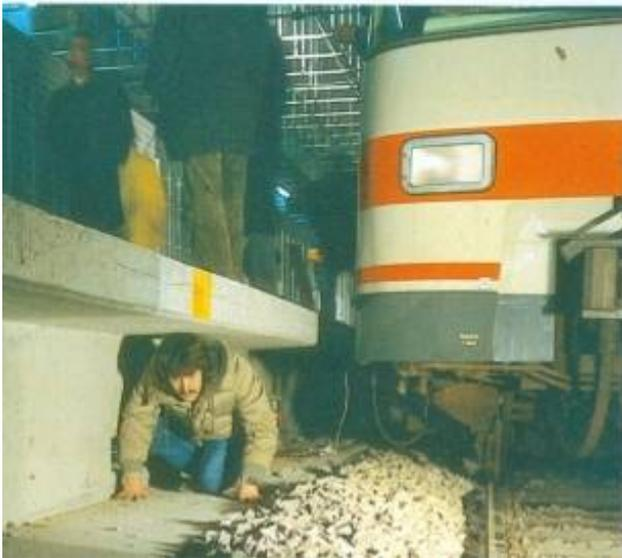
Abb. 7 Innerhalb der unterirdischen Stationen befinden sich unter den vorragenden Bahnsteigkanten 70 cm tiefe Schlupfräume, in die sich eine im Gleis befindliche Person vor einem Zug in Sicherheit bringen kann. Sie dienen auch als Zugangsweg zum Fahrzeug bei Reparatur- und Rettungsarbeiten.
