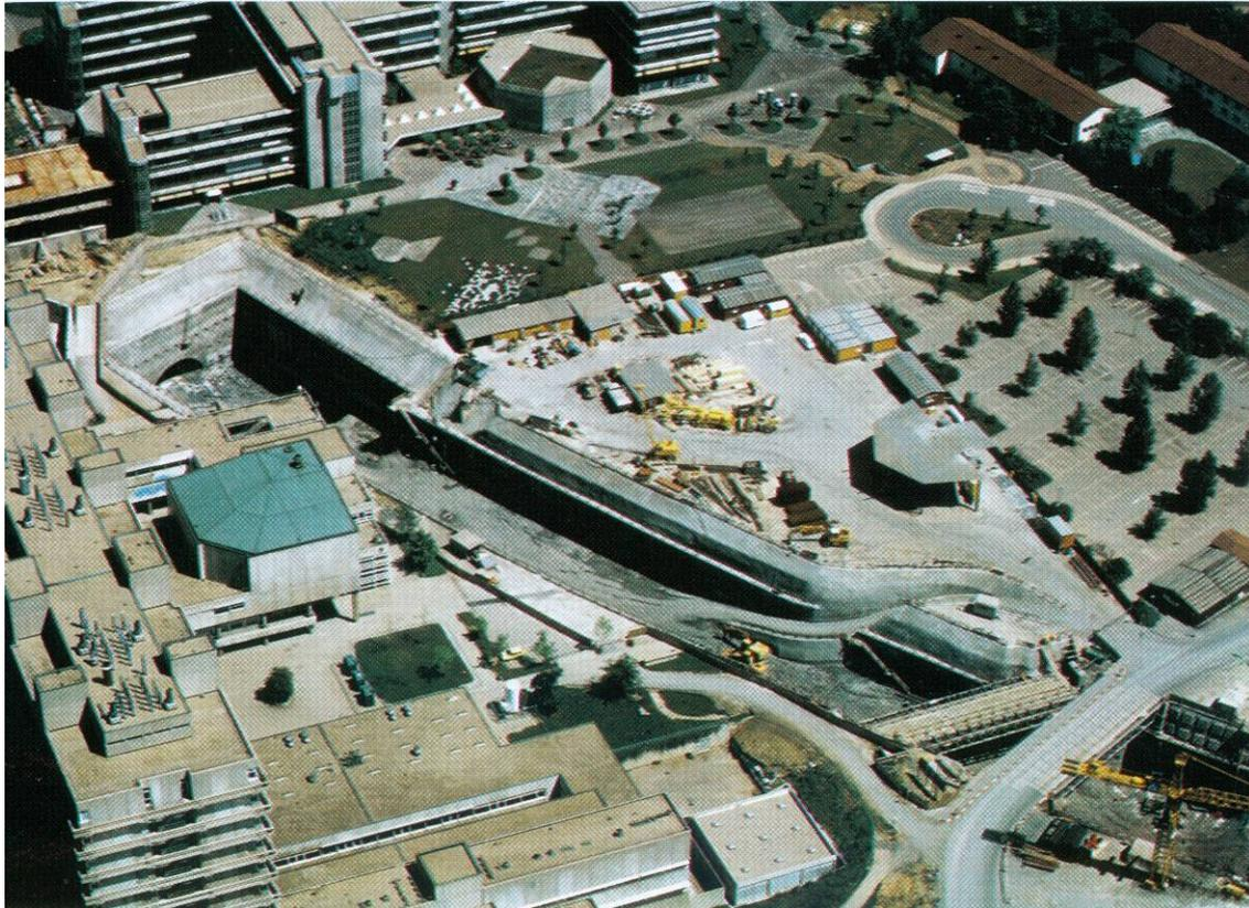
*Abb. 1 Baugrube während der Aushubphase aus der Vogelperspektive. Links ist der Anschluß an den Tunnel (Baulos 14) unter dem Gebäude Pfaffenwaldring 47 (→Station B) zu erkennen.*
