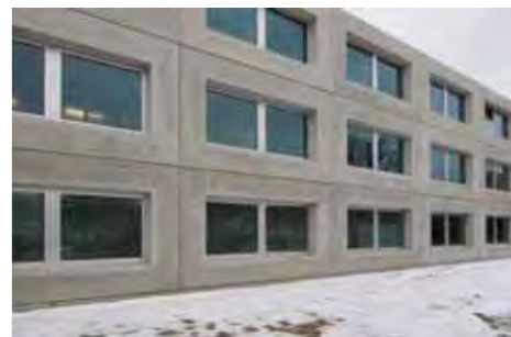
Schnörkellose Klarheit für vernetztes Arbeiten: Das neue SimTech-Gebäude kurz vor der Fertigstellung.
