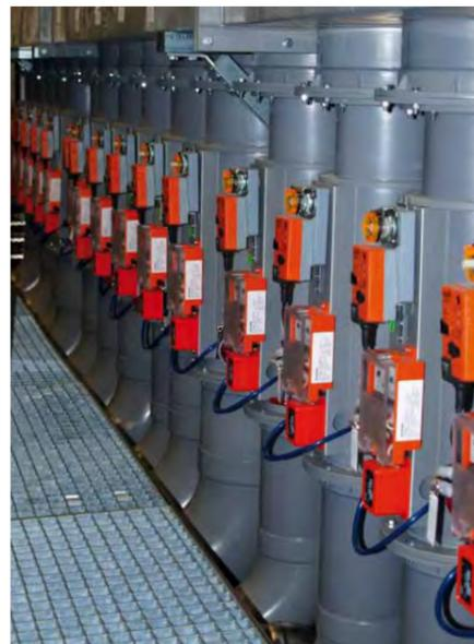
**Neue Volumenstromregler, durch die in Verbindung mit einer neuen Wärmerückgewinnungsanlage sehr viel Energie eingespart wird.**
