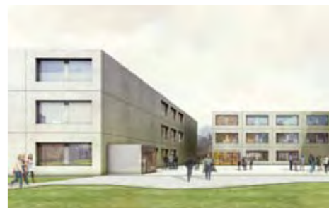
Das neue Forschungszentrum Informatik wurde im Berichtsjahr fast fertig gestellt.
