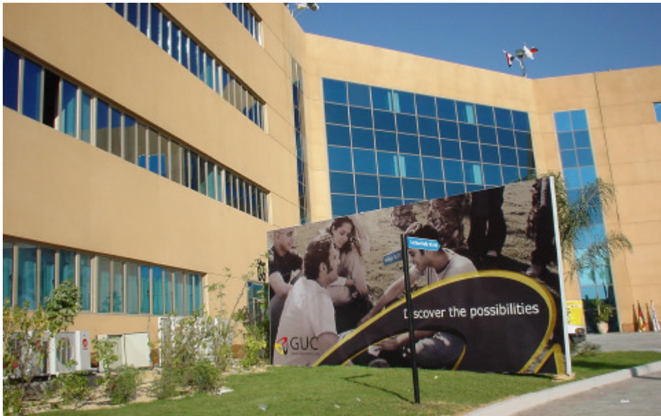
Abb. 2: GUC-Hauptgebäude in Neu-Kairo, 1. Bauabschnitt
