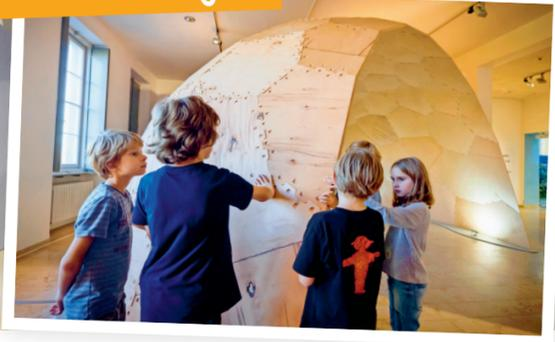
Die Schale eines Seeigels ist dünn, aber dennoch sehr robust. Schließlich muss sie jeder Welle trotzen. Die Schale besteht aus vielen Kalkplättchen, die passgenau aneinandergefügt und miteinander verzahnt sind. Nach diesem Prinzip wurde das Dach eines Holzpavillons gebaut.
