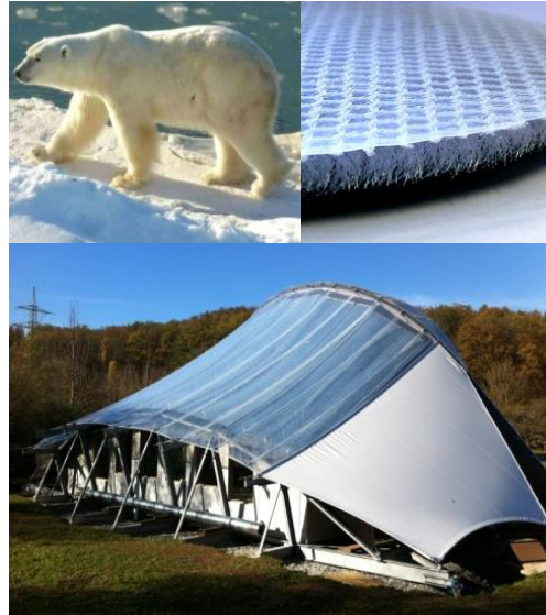
Energieunabhängiges Gebäude mit flexiblen solarthermischen 3D-Textilkollektoren
