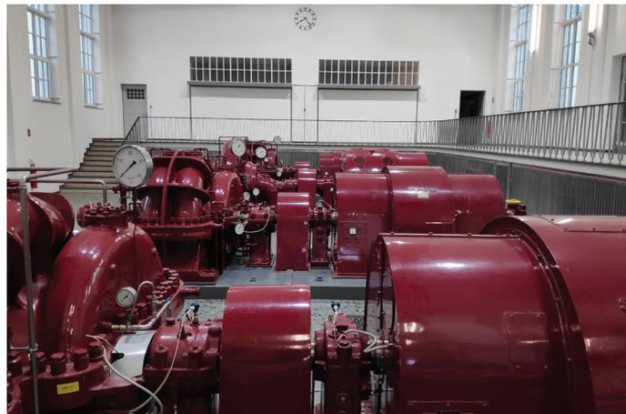
Durch Unterdruck wird das Wasser angehebert und kann somit den Höhenunterschied von 7,4 Meter überwinden. Inzwischen wurde das Wasserwerk nach Langenau verlagert, wo das Wasser weiterverarbeitet und verteilt wird. Dennoch sind Pumpen vorhanden,
