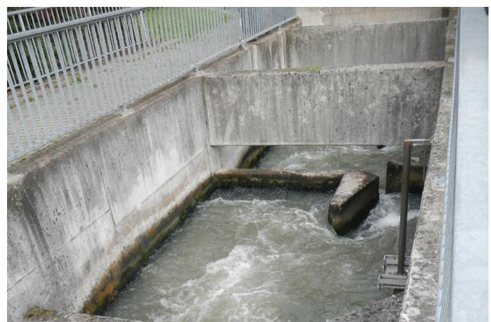
Die Fische werden mit einem Lockstrom zum Eingang der Fischtreppe gelockt, da sich Fische an der Strömung orientieren. Flußabwärts schwimmen die
