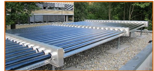
Vakuurröhren-Luftkollektor
