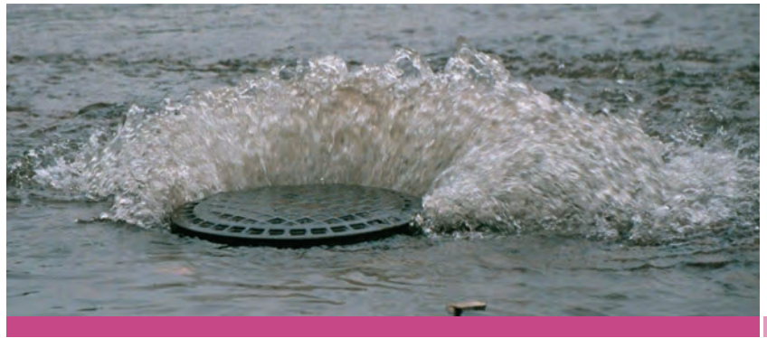
Rückstau im Kanalnetz.
