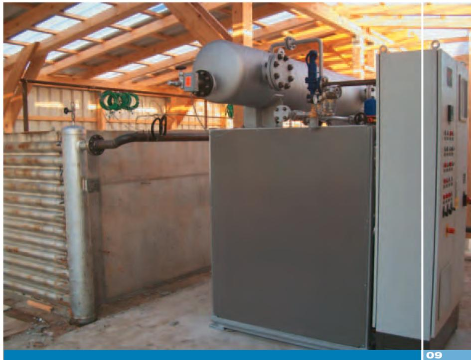
Hochtemperaturbetonspeicher, noch ohne Wärmedämmung
