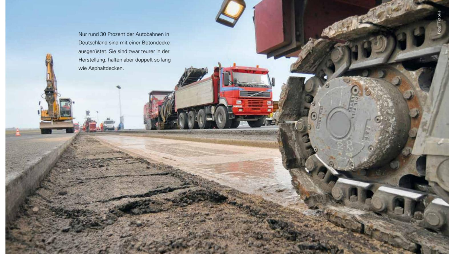
Nur rund 30 Prozent der Autobahnen in Deutschland sind mit einer Betondecke ausgerüstet. Sie sind zwar teurer in der Herstellung, halten aber doppelt so lang wie Asphaltdecken.
