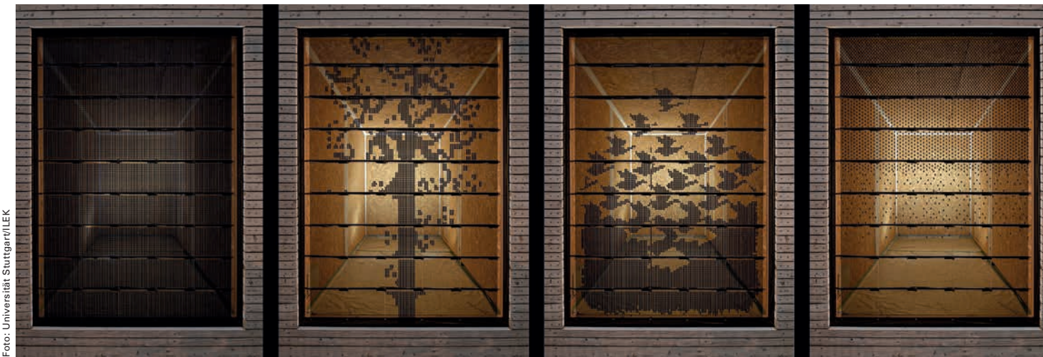
Schaltbare, gepixelte Verglasung in unterschiedlichen Abdunklungen und mit unterschiedlichen Motivdarstellungen.
