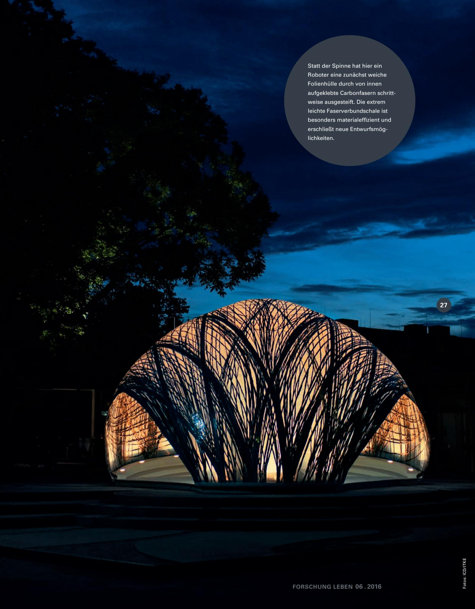
Statt der Spinne hat hier ein Roboter eine zunächst weiche Folienhülle durch von innen aufgeklebte Carbonfasern schrittweise ausgesteift. Die extrem leichte Faserverbundschale ist besonders materialeffizient und erschließt neue Entwurfsmöglichkeiten.
