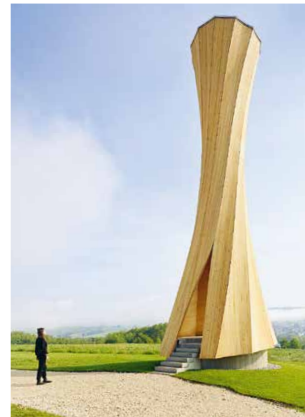
Steil geschraubt: Der Urbach Tower ist 14 Meter hoch.
