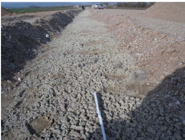
Bild 2: Aufgequollenes Planum durch Treibmineralien BAB A71 [4]
