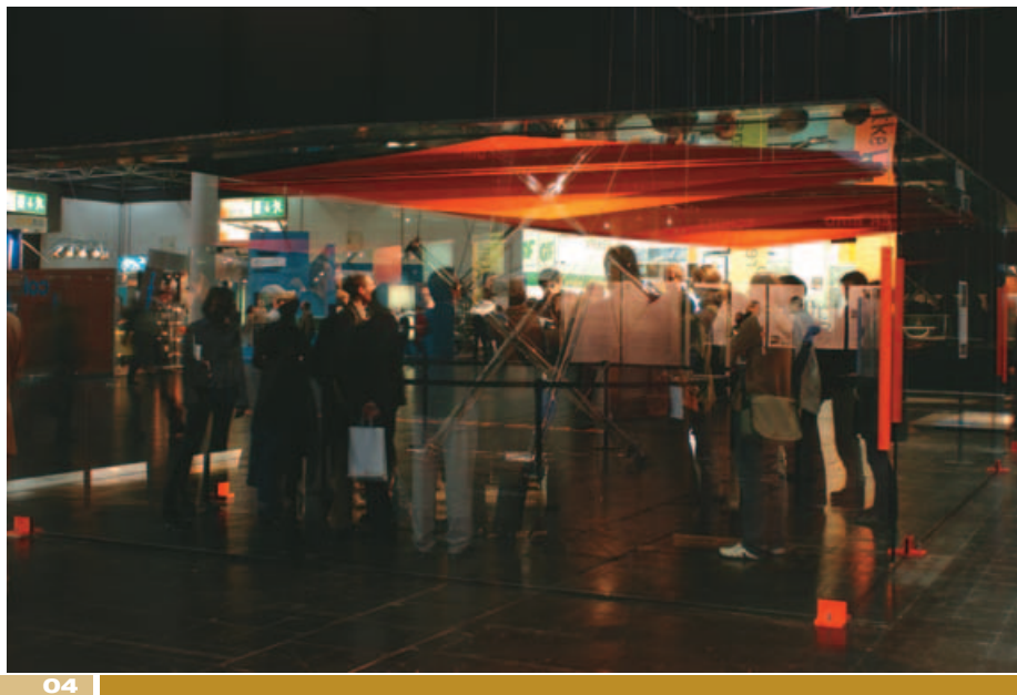
GFK-Pavillon auf der glasstec 2002 aus acht Glasscheiben 6 m x 2,50 m und sechs aufgeklebten GFK-Trägern (Entwurf und Herstellung itke).
