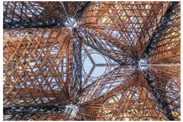
Leicht und luftig: Blick in das Geflecht aus gewickelten Flachsfasern
